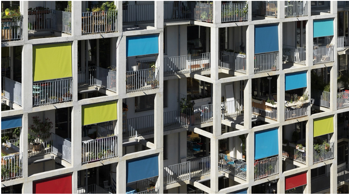
Figure 1 : Bâtiment équipé de casquettes à Soubeyran (Genève)
