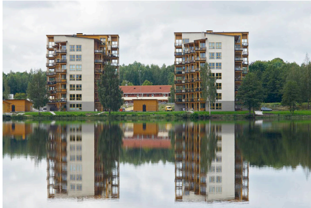
2 immeubles en bois de Limnologen à Växjö en Suède. Chaque immeuble compte 33 appartements et a nécessité l'utilisation de 500 tonnes de bois.
