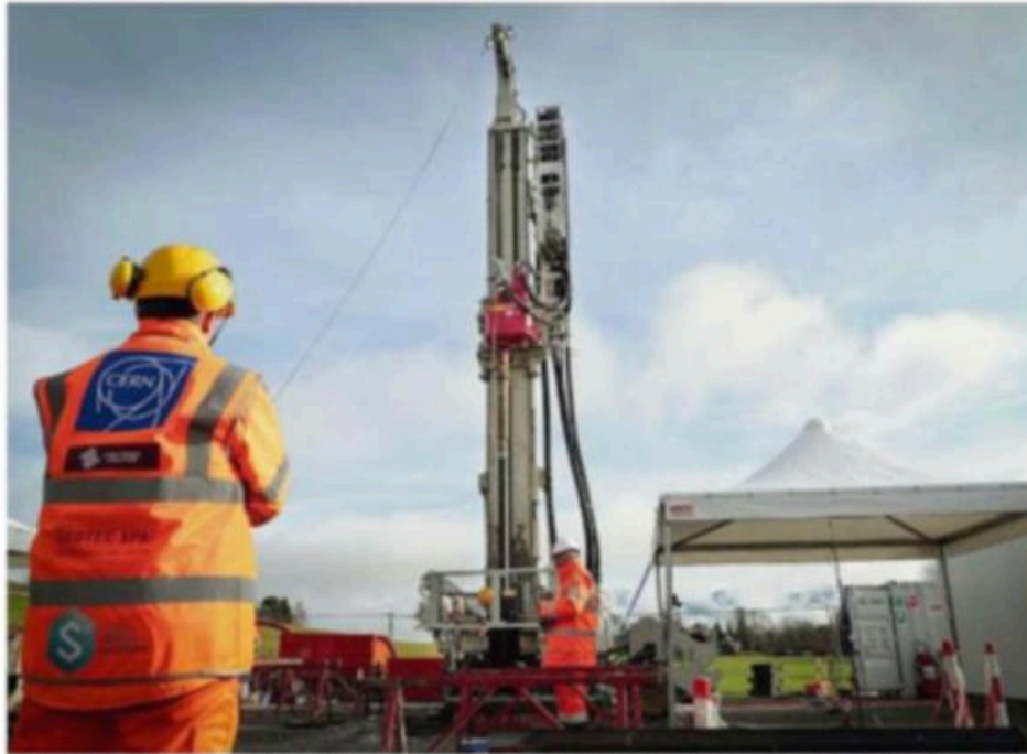
Un carottage près de La Roche-sur-Furon (F). En novembre, dans le cadre des études géologiques afin de déterminer le meilleur emplacement du futur collisionneur circulaire. De telles études de terrain doivent aussi se dérouler dans plusieurs communes genevoises. LAURENT LUTHE
