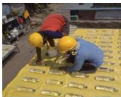
Essai d'un des 11 dispositifs prototypes pour isoler le toit d'habitats informels à Chennai. Photo Fairconditioning.
